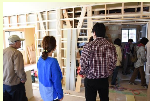
三光施工中物件を見学しました。
